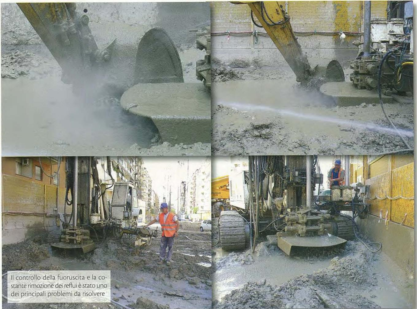
Il controllo della fuoriuscita e la costante rimozione dei reflui è stato uno dei principali problemi da risolvere
