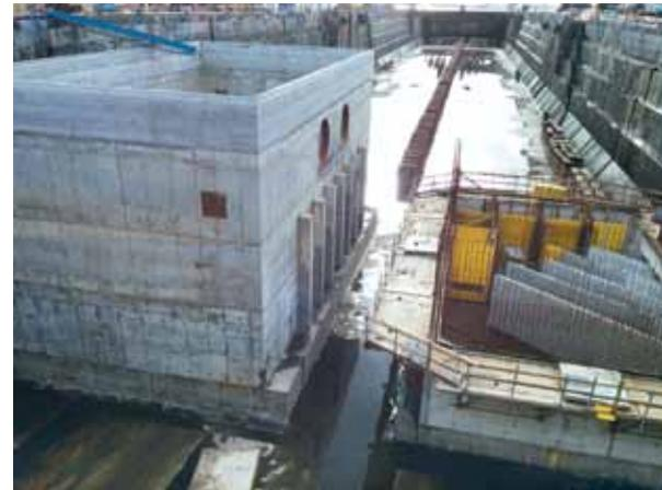
Costruzione in bacino di carenaggio dei cassoni in c.a. dell'opera di presa e di scarico della centrale elettrica
