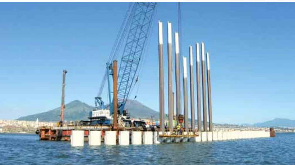
nica dei cosiddetti "pali a spostamento laterale" (nome tecnico Discrepiles, o Displacement Piles).
