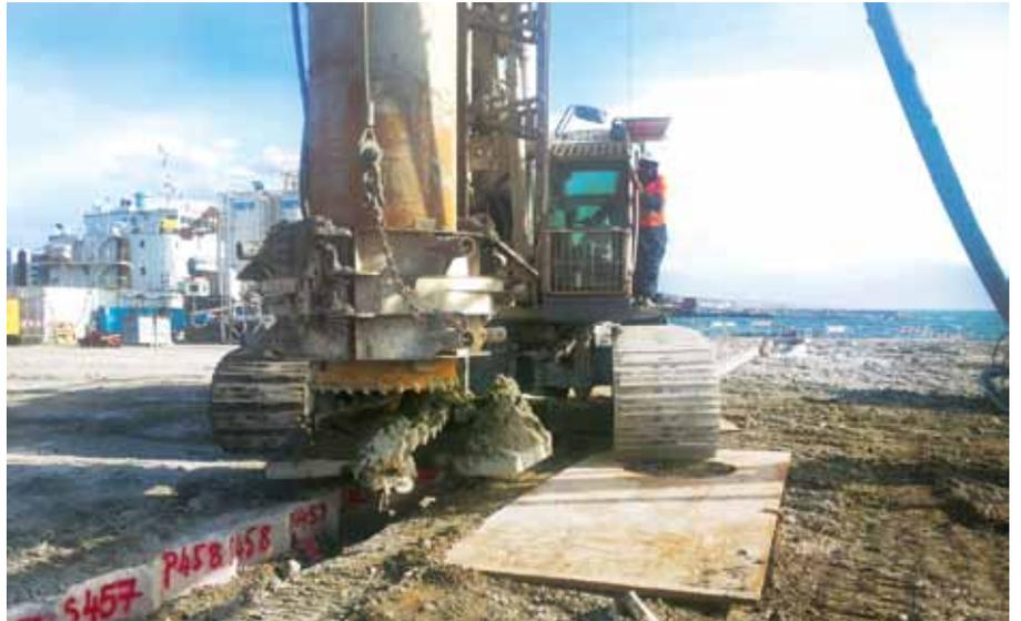
Particolare della realizzazione del diaframma plastico lungo il Molo del Progresso
