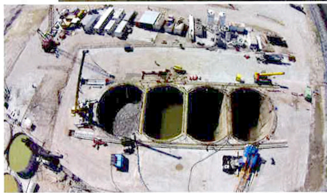
Excavación celdas bajo agua.
